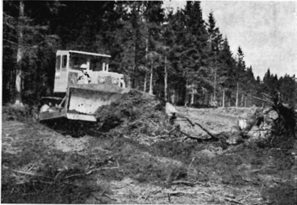
Fig. 3. Stødrydning med 125 HK bulldozer i parcel I i Ndr. Feldborg plantage.
