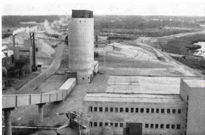
Fig. 6. Udsigt fra kogetårnet på Mörrums Bruk mod råtræpladsen. Til venstre kemikaliegenvindingsanlæg, i midten flis- og barksiloer og til højre i forgrunden vandrensingsanlæg.
