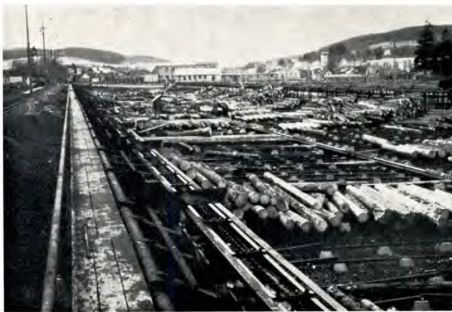
Fig. 2. Sorteringsanlæg ved oparbejdningsplads »Volary«. Udsorteringen er programmeret og foregår automatisk. Transportbåndet i midten af billedet går ind i savværket.
