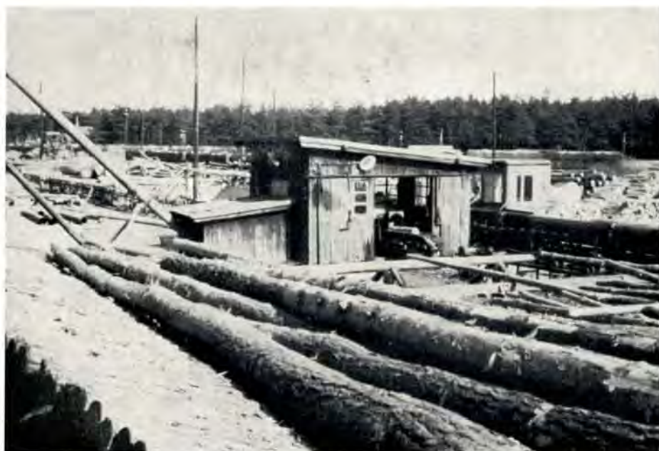
Fig. 4. Oparbejdningsplads under Forstdirektionen Stratnice. Kapacitet 25–30.000 m 3 årligt fordelt på alle træarter og på ialt 60 forskellige sortimenter. Bemanding ca. 7 mand og en værkfører.
