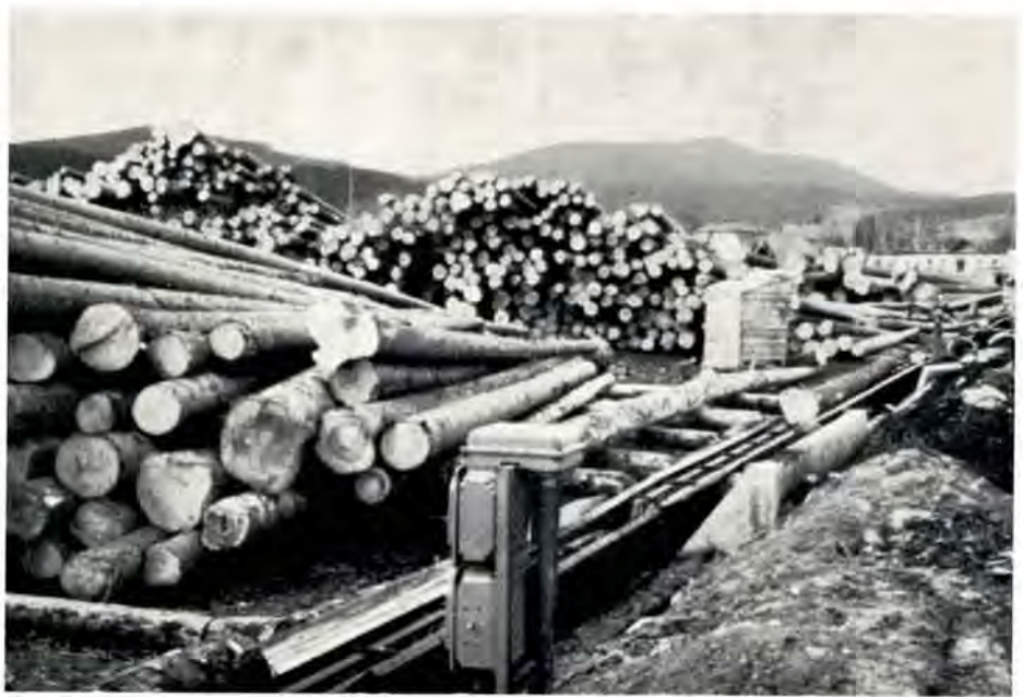
Fig. 1. Oparbejdningsplads »Volary«. Max. kapacitet 150.000 m 3 årligt. Nyt moderne anlæg grænsende direkte op til spånpladefabrik og savværk.
