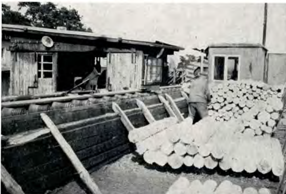
Fig. 5. Oparbejdningsplads Stratnice. I det store skur foregår afbarkningen og i det lille er styrepult for afkortning og sortering. Arbejderen på billedet er overflødig.
