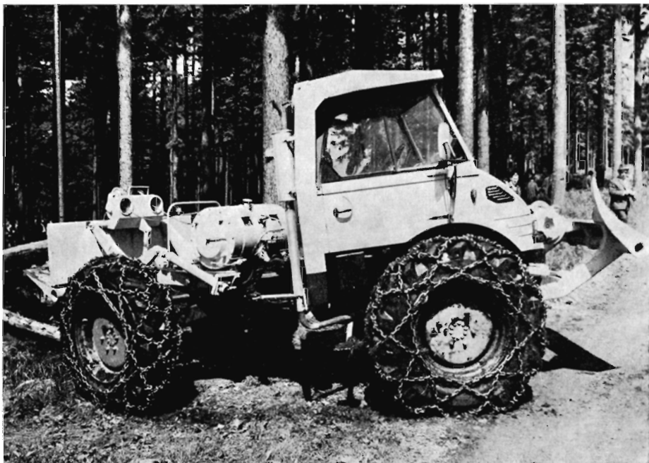
Denne model af den kendte UNIMOG, den såkaldte UNIKNICK, er en nykonstruktion. Den er rammestyrret og viste særdeles gode terrængående egenskaber. Prisen er ca. 150.000 kr.
