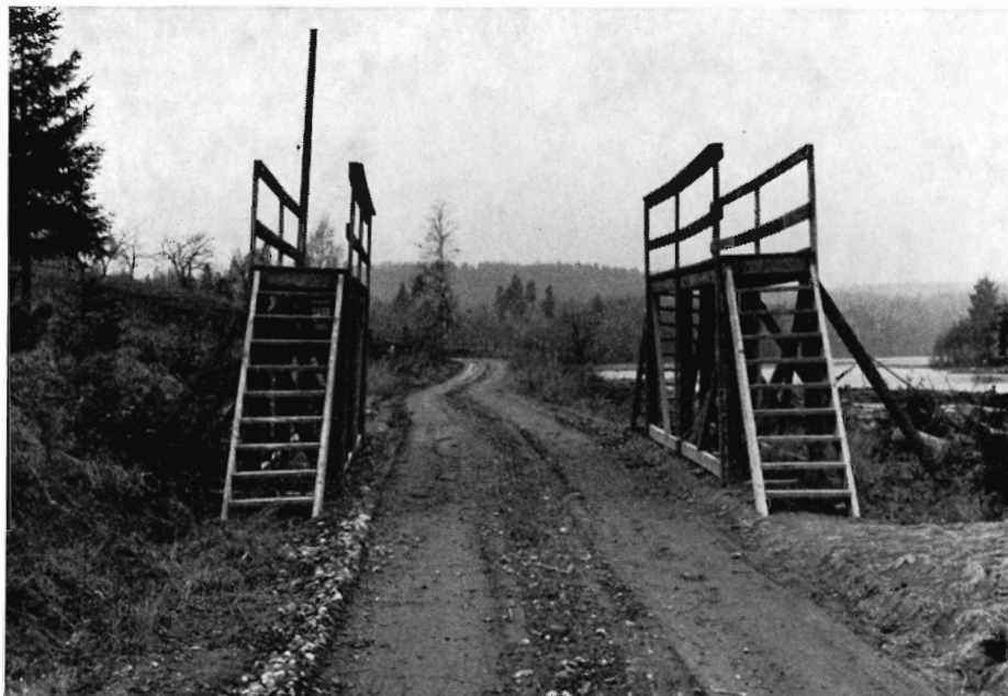
Plads til opmåling af træ på lastbiler. Opmåling af træ på lastbiler forekommer almindeligt i Norge.
