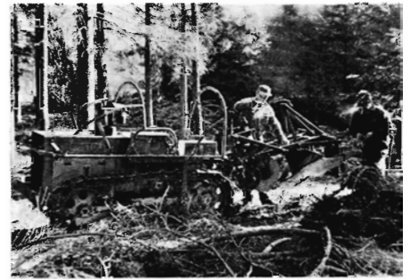
Fig. 1. Liftophængt Tolneplov monteret på Bristol D 30 bæltetraktor.
