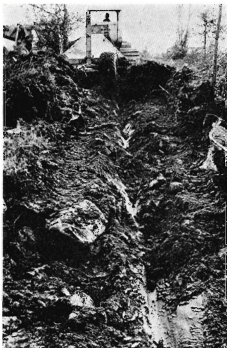
Hyggepløjning under udførsel
