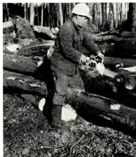
Fig. 4. Stammemetoden. Ved fast vej sammenskubbes stammerne med traktoren, hvorefter de fleste stammer vil kunne afkortes oppe i bunken helt fri af jorden.
