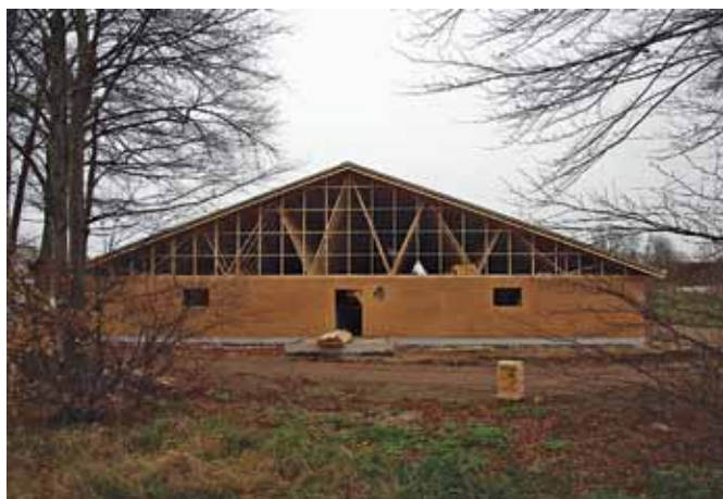
Nåletræ indgår i tagkonstruktionen, hér som høvlede gitterspær. Foto: Frands Fraas Nielsen
