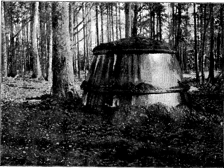
Fig. 30. Skorstenene og Trækventiler er fjernede; Ovnene er slukket. Cheminées et évents ont été écartés; le four est éteint.
