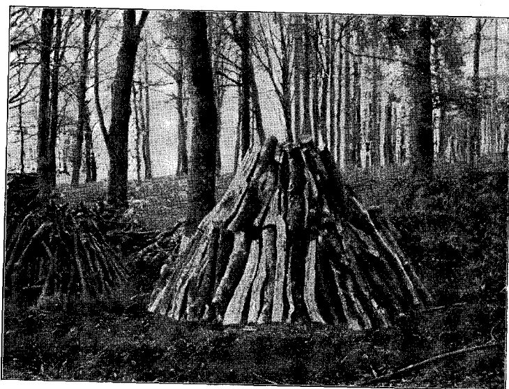
Fig. 8. Milen'er færdigbygget. Yderst en Del tynde eller kløvede Brændestykker. La meüle achevée. Le plus en dehors, des morceaux de bois minces ou fendus.
