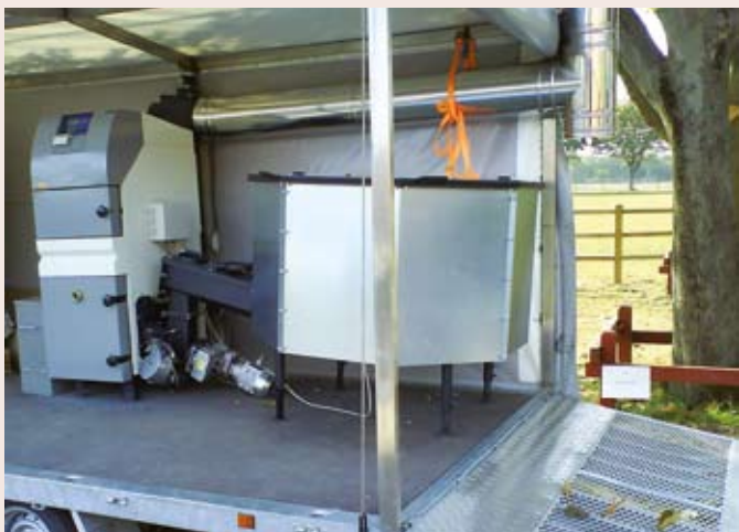
Figur 2. Benekov S 25 og S 50 flisstokere er udstyret med et patentanmeldt brændehoved, som hindrer fastbrænding af slagger på brændehovedet.
