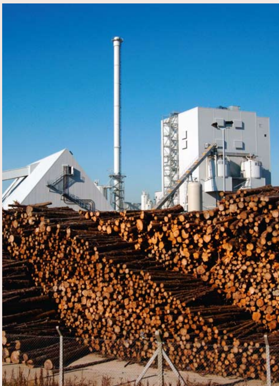
Figur 1. Steven's Croft kraftværket nær Lockerbie i Skotland blev indviet i marts 2008 og er det største flisfyrede kraftværk i Storbritannien.
