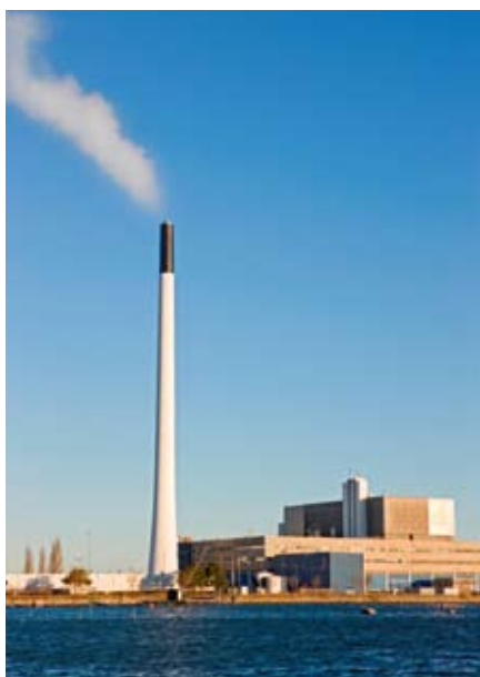
Amagerforbrænding bruger trærødder med jord når ovnene skal tændes og slukkes.
