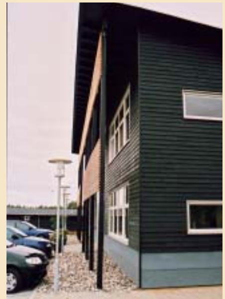
Et stort tagudhæng beskytter facaden mod regnvand.
