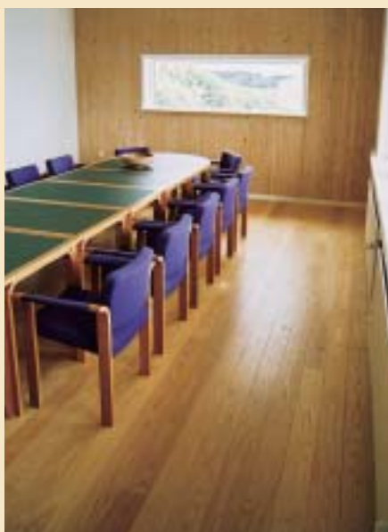
Møderummet har gulvplanker af ask, mens de massive træelementer ses i endevæggen.
