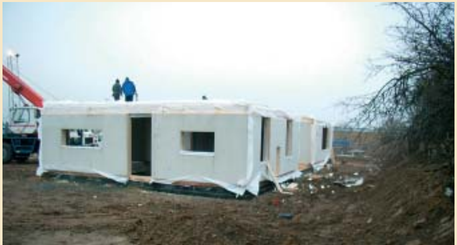
Huset blev leveret som færdige vægelementer af massivt træ, indklædt i gipsplader.
