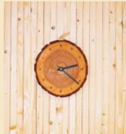
Væggene består af massive træelementer, som er opbygget af granplanker. Plankerne ses kun i husets endevægge, mens de øvrige vægge er inddækket med gipsplader. Uret er lavet af douglasgran.
