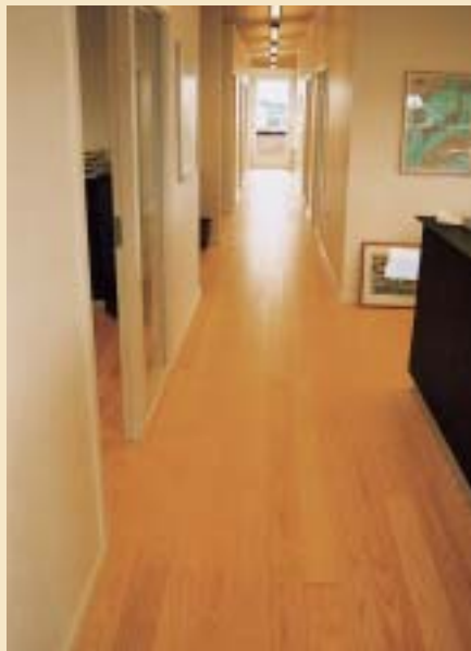
På førstesalen er der lagt skibsplanker af asketræ.
