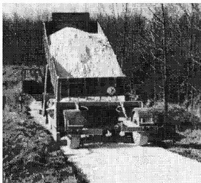
Levering og udlægning af grus, sten og andre vejmaterialer direkte fra lastbil med patentanmeldt vejafrettermaskine.
