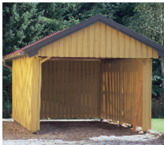
Carport hjemmebygget af selvsavede planker.
