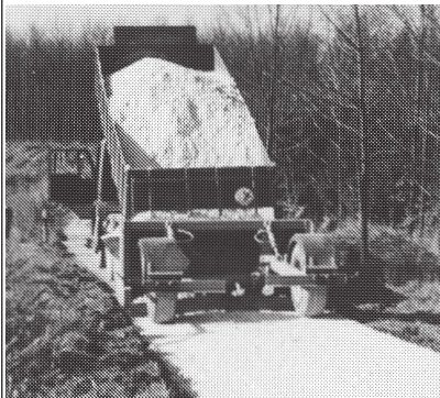
Levering og udlægning af grus, sten og andre vejmaterialer direkte fra lastbil med patentanmeldt vejafretermaskine.
