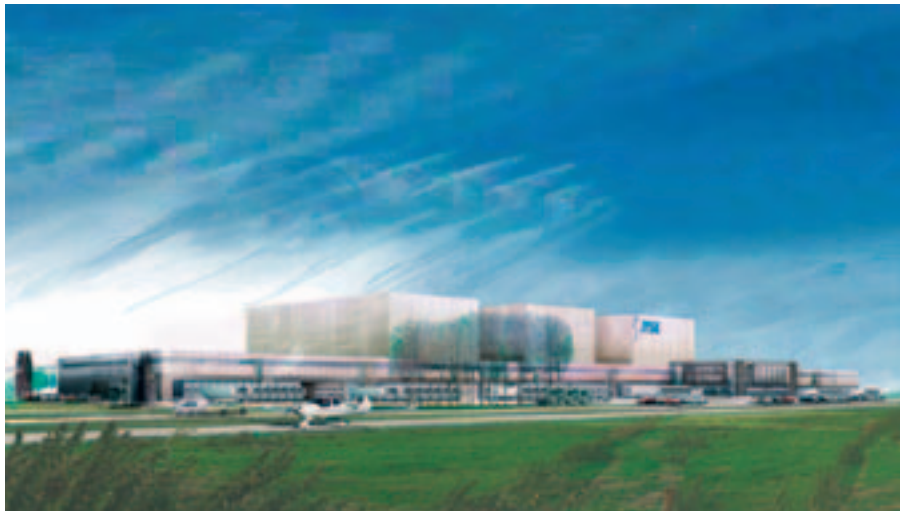
Det nye centrallager for JYSK bliver den største bygning der er givet byggetilladelse til i Danmark. Det rummer bl.a. 3 fuldautomatiske kranhøjlagre på 40 meters højde. Tegning: AK83 Arkitektkontoret.
