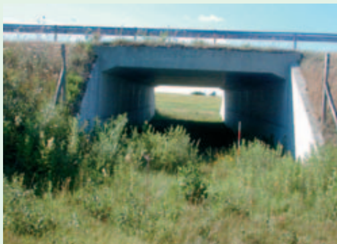
Foto 3. Rektangulær tørpassage ved Dybvad. Foto: DMU 2006.
