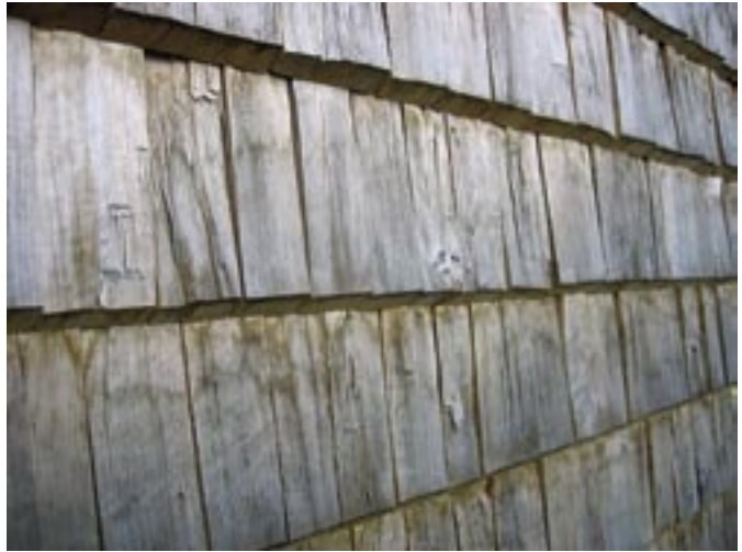
Spånene på kirkens yderside er lavet af asp som er flækket frem for at være savskåret. Det giver længere holdbarhed.
