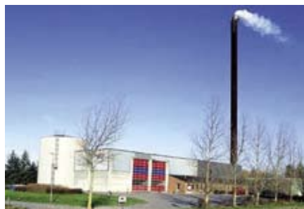
Fjerritslev Fjernvarme bruger op til 70 tons flis i døgn.
