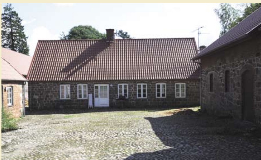
Avlsgården omfatter to huse samt (til højre) en gammel stald.
