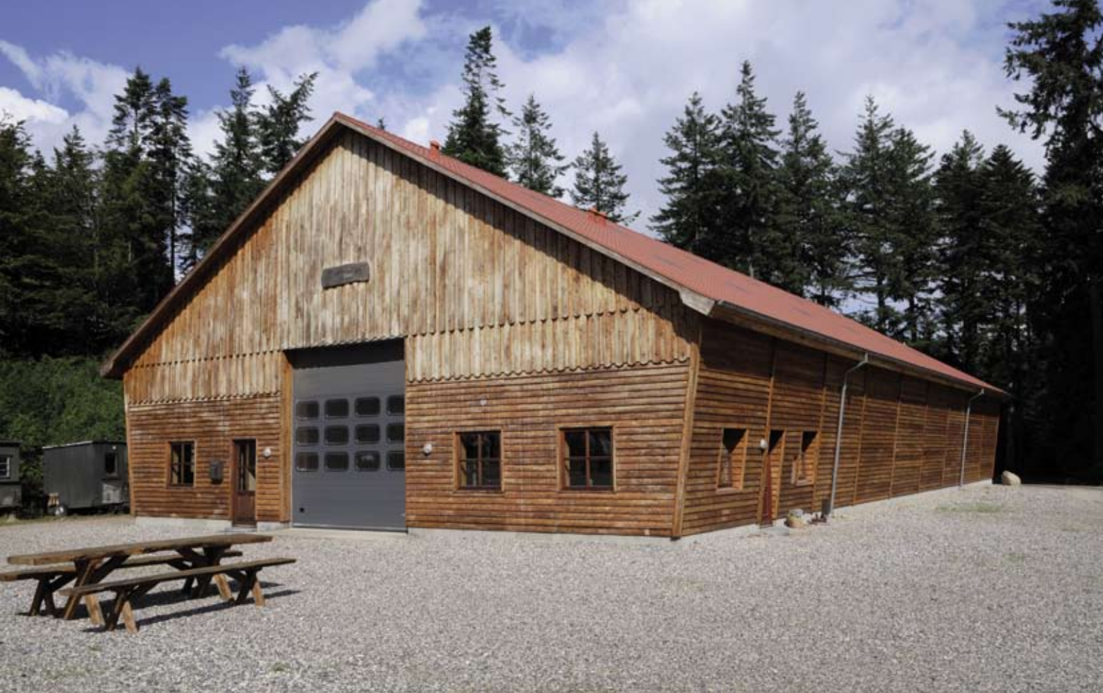
Maskinhallen er et flot eksempel på træbyggeri – men kan anvendes til meget andet.
