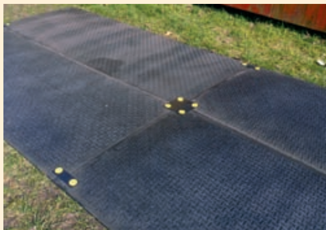
Med køreplader undgår man skader fra store maskiner.
