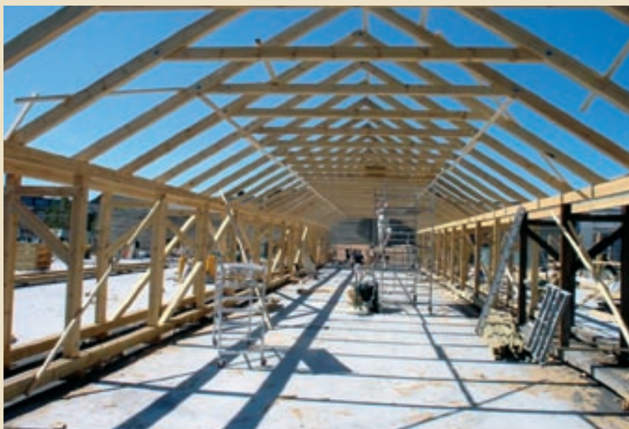
De nye skure under konstruktion.
