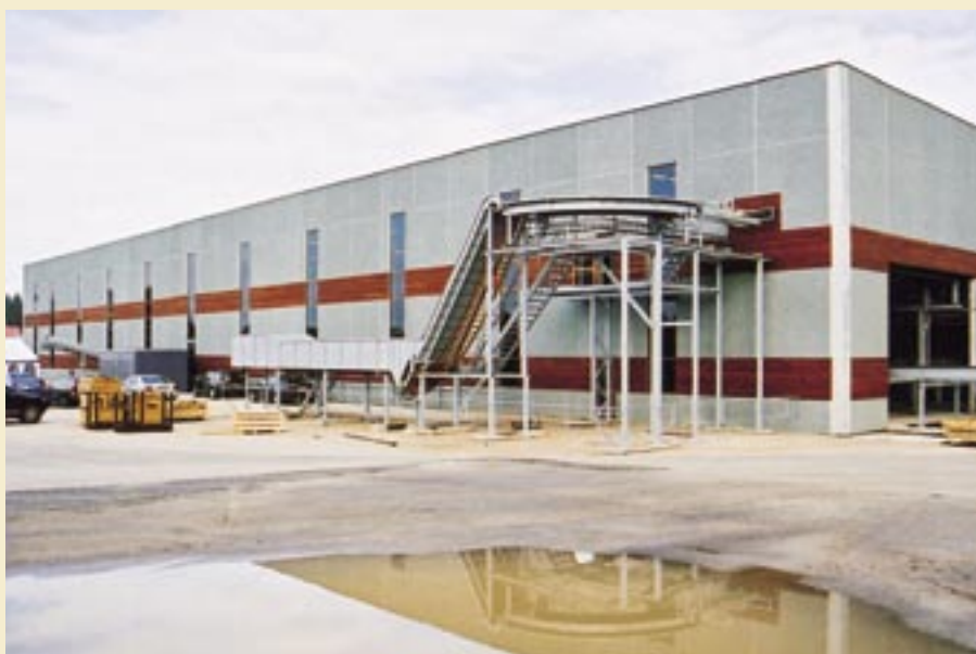
Der er meget lidt træ i den nye savværksbygning. Den er lavet af betonelementer med lidt bejdset træ som dekoration.
