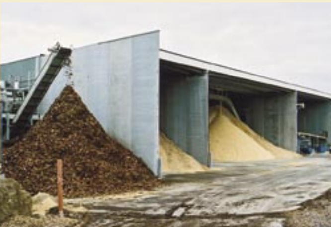
Foto 9. På bagsiden af bygningen ligger restprodukterne – bark, flis og savsmuld.
