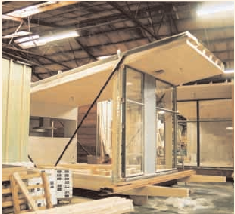
Prototype på et parcelhus der laves på fabrikken i fem sektioner og kan stilles op på få timer.
