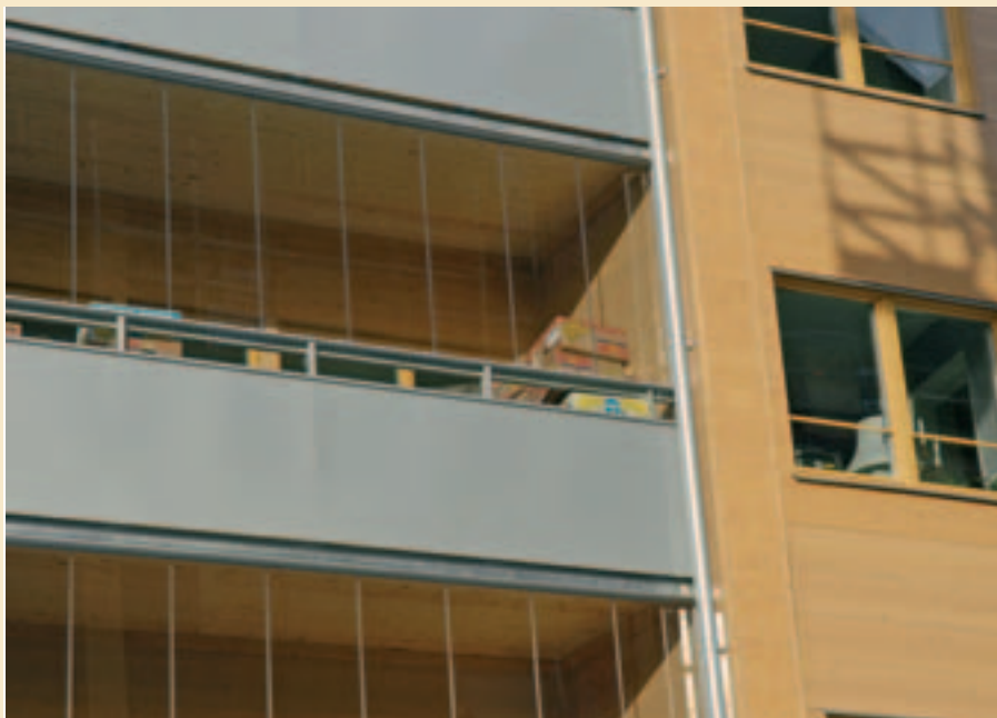
Der er brugt træ i alle bærende konstruktioner og i facaden.
