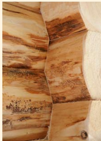
Bjælkerne fastholdes i hjørnerne med en knudesamling.
