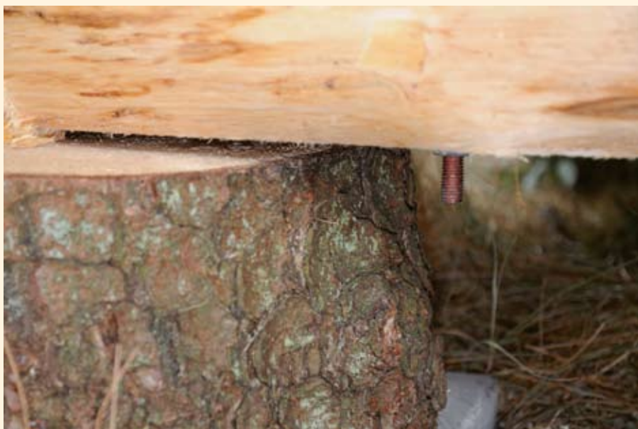
Shelteret hviler på rodklodser af gran og en betonflise. Til højre ses enden af den gevindstang som holder bjælkerne sammen.
