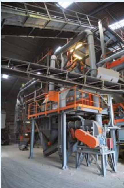
Bygningsaffald og paller bliver ned-delt så det kan indgå i produktionen.
