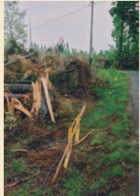
I de små samfund er næsten al strømforsyning baseret på luftledninger, og der gik næsten to måneder før alle havde strøm. Nu er der mange steder udlagt midlertidige kabler langs vejene, omhyggeligt afmærket med gult.
