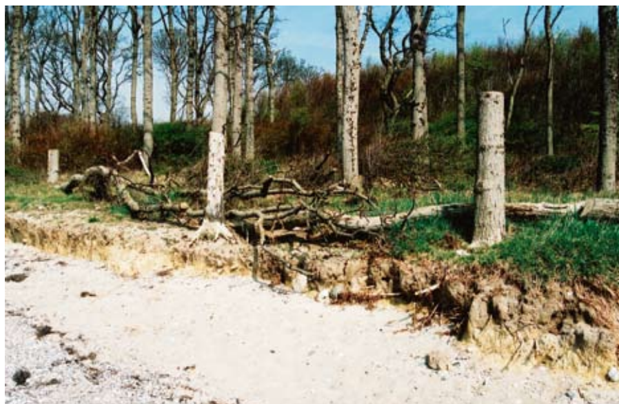
De yderste træer er skåret ned, og kvaset er lagt langs kanten.
