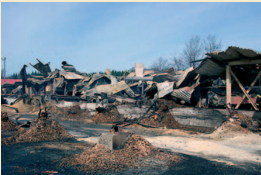
Det tager mindst et halvt år at genopbygge de ødelagte dele af savværket. Foto: Nørlund.
