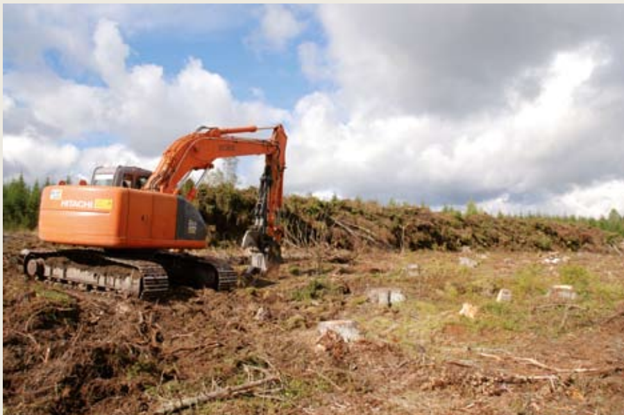
Figur 2. Areal klargjort til stødrydning.
