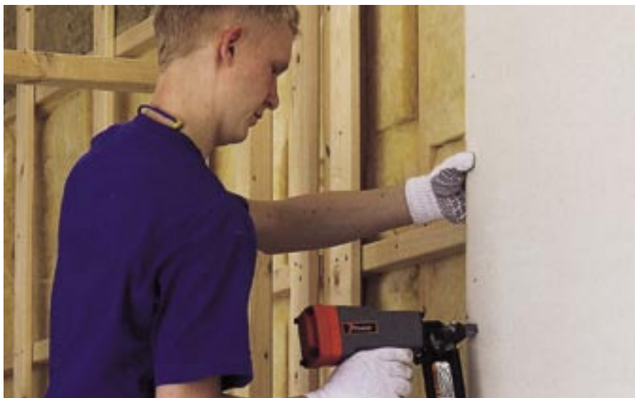
Fibergipsplader med 20% træfibre er velegnede til produktion af byggeelementer på fabrik og kan monteres med klammepistol.
