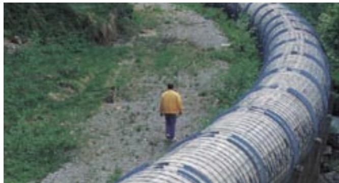
Turbineledning til Kungsfors kraftværk i Sandviken.
