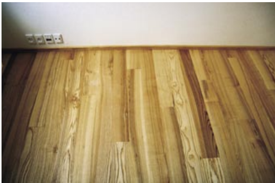
Brunkernet ask er anvendt i stort omfang i et nybygget alumnat på Sorø Akademi. Til gulve, dørtrin, senge, beklædning mv. Se mere i Skoven 2/02, side 67.
