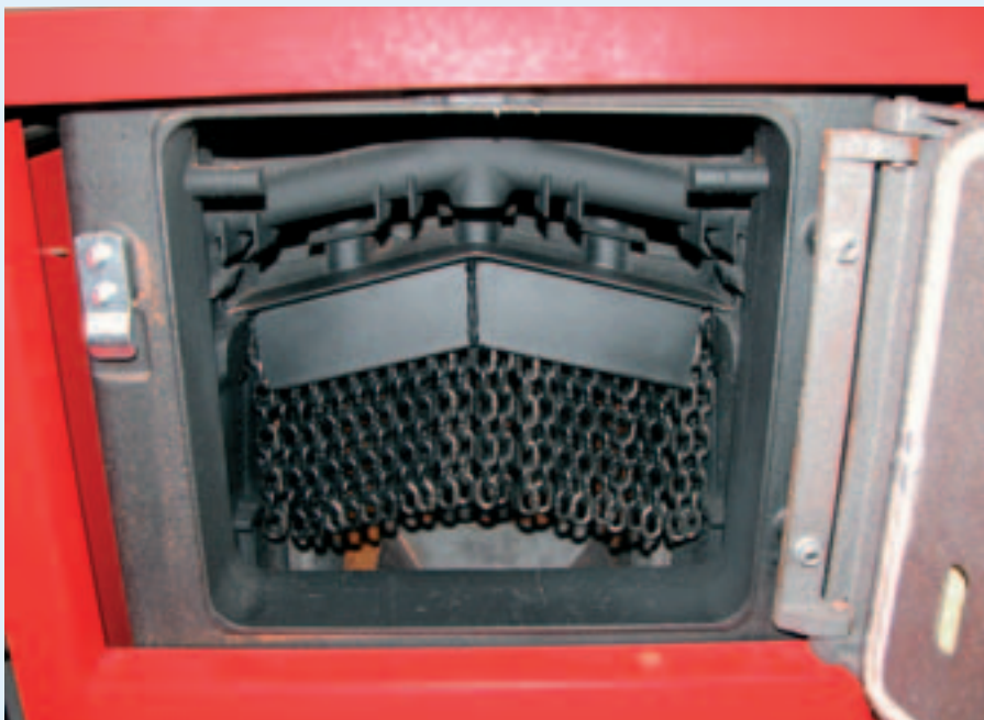
Foto 5. En kædespærre fra Smedegården er en uhyre simpel metode til at give en bedre forbrænding og fjerne næsten alle støvpartikler fra røgen. Udstyret er patentbeskyttet. Det var en trestjernet europæisk nyhed på Agromek.
