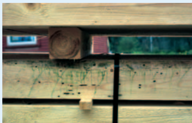
Figur 4. Skader på veddet af almindelig granbarkbuk (borehuller). (Foto: H.P. Ravn).
