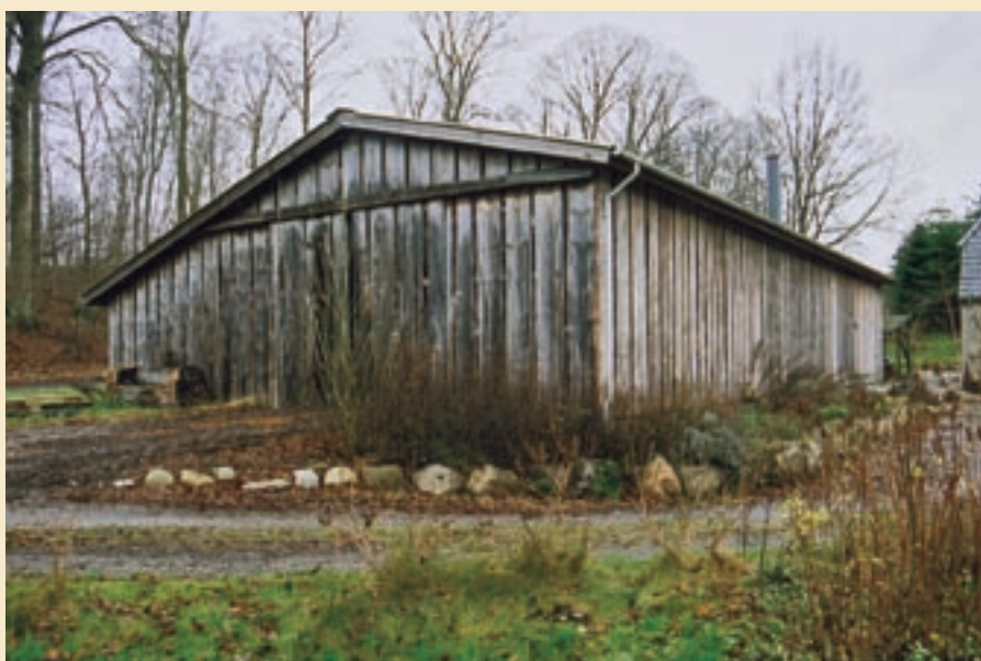
En bindingsværklade blev knust under orkanen i 1999. I dag står der et maskinhus lavet af østrigsk fyr fra stormfaldet.
