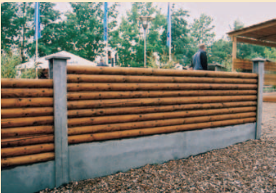
Nyt hegn i varmebehandlede rundstokke af gran og med stolper og bundplanke i fiberbeton.
